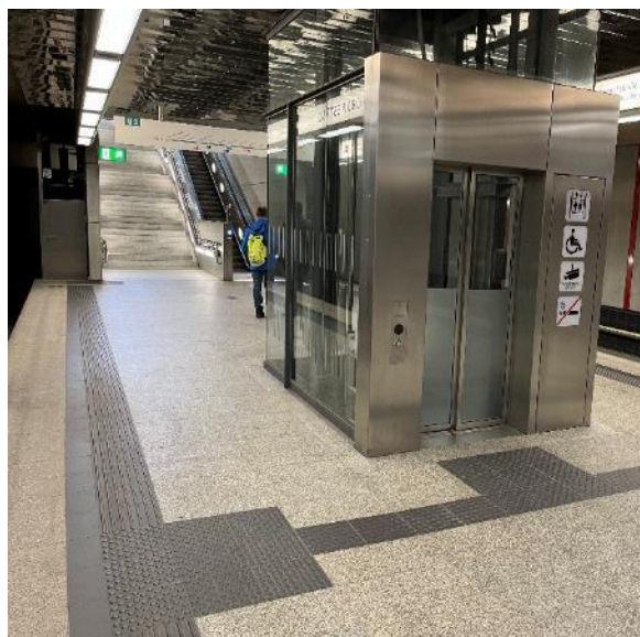
Bild FS17- 4: Aufzug in der Haltestelle Nordwestring, taktiler Leitsystem (Foto: Lutz)
