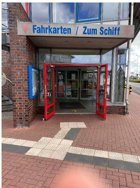
Bild FS03- 1: Zugang zum Hafenterminal mit Meldestelle für Hilfeleistungen, Bodenindikatorbasiertes Leitsystem mit visuell und taktile kontrastierendem Begleitstreifen, visuell kontrastierende Eingangstür (Foto: Boenke)
