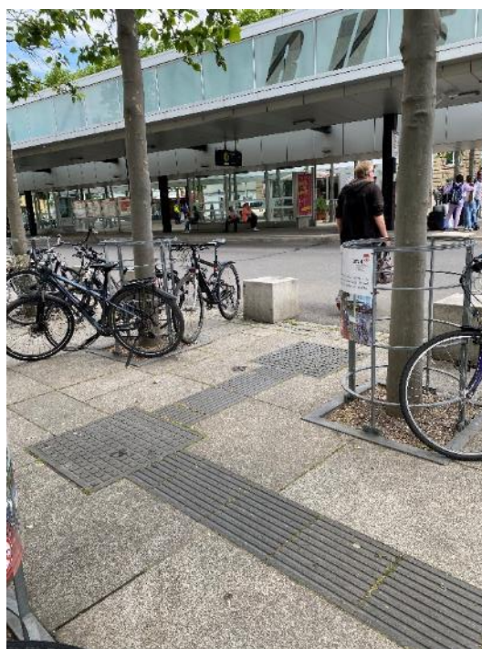
Bild FS02- 1415: Leitstreifen mit Abzweigungsfeld am Übergang vom Vorplatz zum ZOB (Foto: Eichmann)
