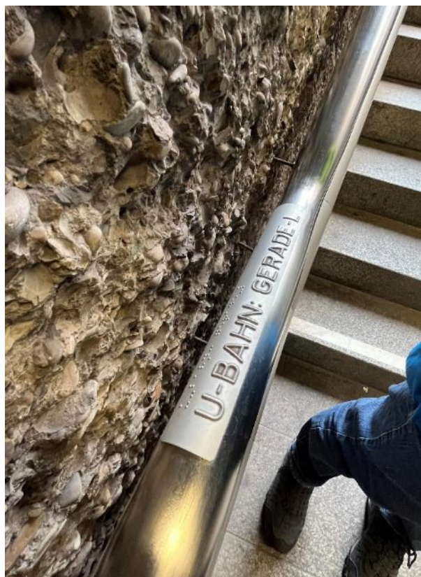
Bild FS17- 7: Handlaufbeschriftung an der Haltestelle Rathenauplatz (Foto: Lutz)
