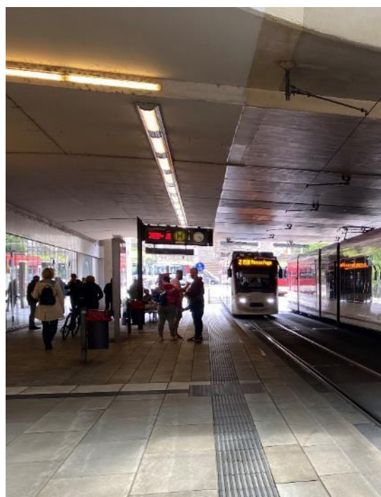
Bild FS02- 9: ÖPNV-Haltestelle unter der Gleisunterführung mit Bodenindikator-basiertem Leitsystem (Foto: Eichmann)
