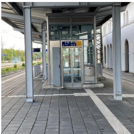
Bild FS09- 2: Bahnsteige mit Aufzügen und kontrastreichen Bodenindikatoren (Foto: Eichmann)
