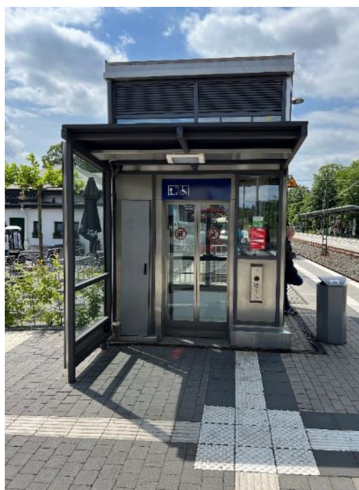
Bild FS06- 5: Aufzug am Kopf des Hausbahnsteigs (direkter Zugang zu den Bushaltestellen) mit Bodenindikator-basiertem Leit-system (Foto: Boenke)
