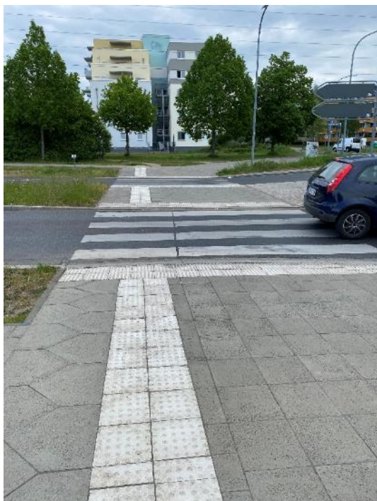
Bild FS18- 6: FGÜ mit Bodenindikatoren, Kreisverkehr Heinrich-Rau-Str./Junckerstraße (Foto: Eichmann)
