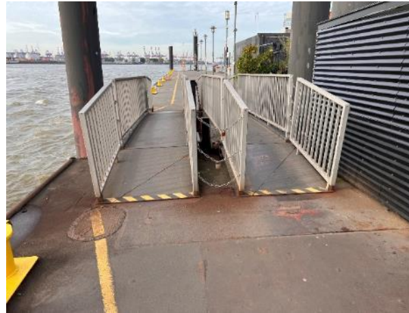
Bild FS19- 11: Enge Stege mit Kanten und Rampen als Verbindung zwischen zwei Anlegern (Foto: Boenke)
