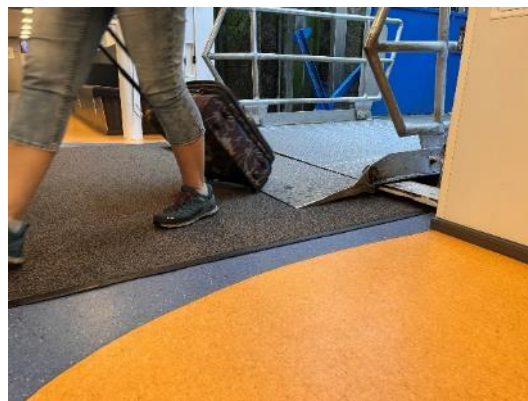
Bild FS03- 6: Niveaugleicher Zugang zum Schiff (Fahrgastbrücke, Schiffsseite) mit visuell kontrastierender Bodenmarkierung (Foto: Boenke)
