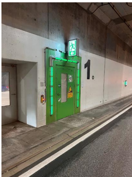
Bild FS12- 2: Auffällig gekennzeichnete Notausgang (Foto: Boenke)
