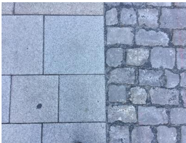
Bild FS01- 2: Vergleich der Oberflächen der neuen Gehbahn und des alten Pflasters (Foto: Boenke)
