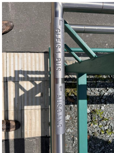
Bild FS11- 9: Taktile Handlaufbeschriftung an einem Haltepunkt im Netz des Chemnitzer Modells (Foto: Boenke)
