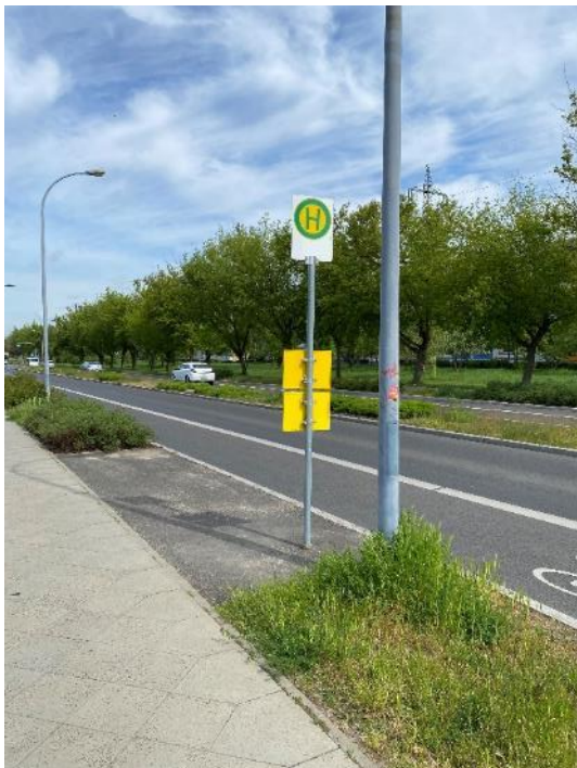
Bild FS18- 12: Provisorische Bushaltestelle, nicht barrierefrei (Foto: Eichmann)
