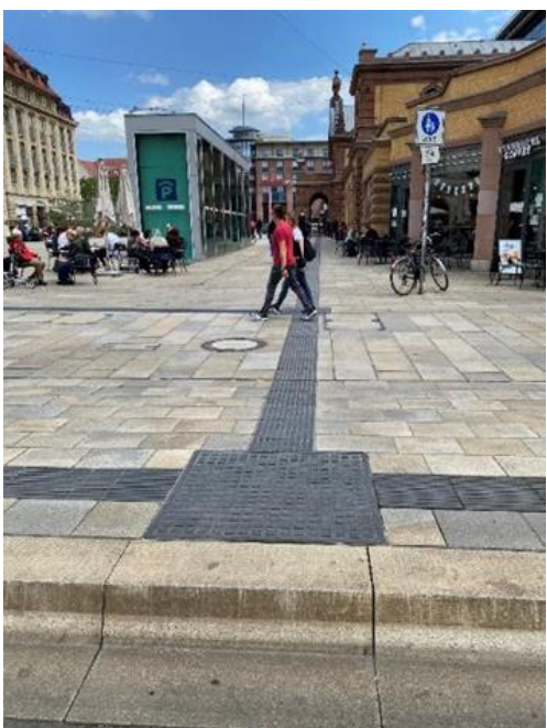
Bild FS02- 4: Teil des durchgängigen Bodenindikator-basierten Leitsystems zwischen Bahnhof, ÖSPV-Haltestellen und Vorplatz (Foto: Eichmann)
