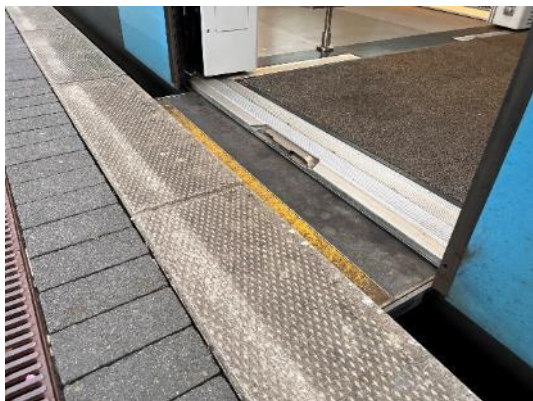
Bild FS03- 2: Weitgehend niveaugleicher Fahrgastwechsel in den Regionalzug am Bahnsteig Emden Außenhafen (Foto: Boenke)
