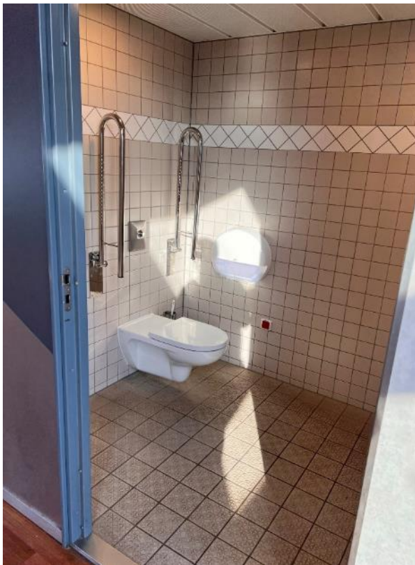
Bild FS19- 8: Barrierefreie Sanitäreanlage auf einer der Fähren (Foto: Boenke)
