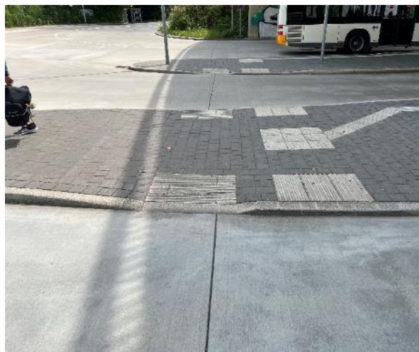
Bild FS06- 7: Querungsstellen an der Haltestelleninsel, getrennte Querungsstelle mit differenzierter Bordhöhe (Foto: Lutz)
