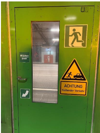
Bild FS12- 6: Hinweistexte als Texte und Sinnbilder auf der Notausgangstür (Foto: Boenke)
