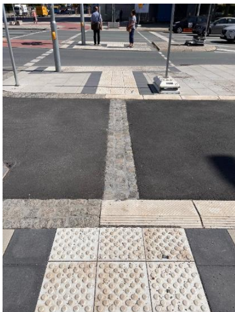
Bild FS11- 6: Querungsstelle mit Querung eines Radwegs und Auffindestreifen als sonstiges Leitelement 35 (Foto: Boenke)
