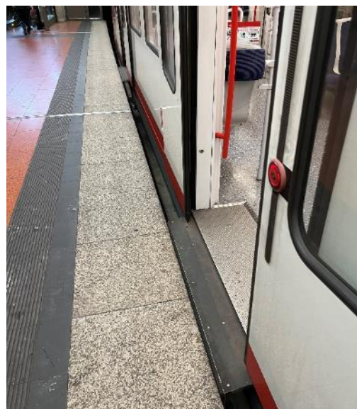
Bild FS17- 5: Spaltüberbrückung zwischen Zug und Bahnsteigkante, taktiler Leitsystem (Foto: Lutz)
