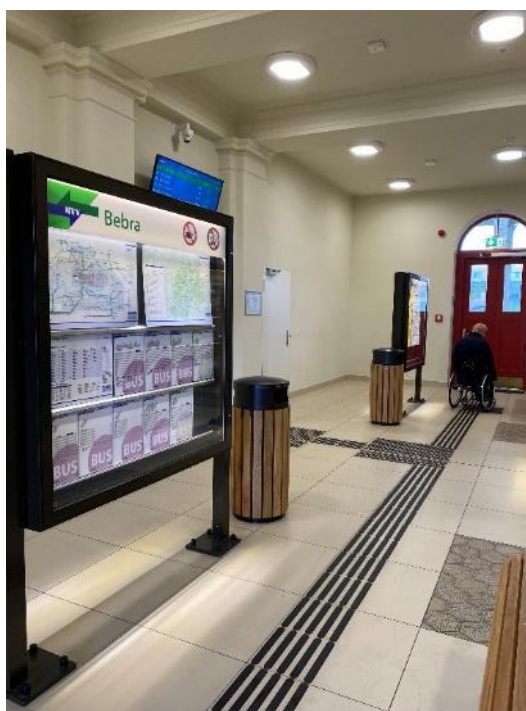
Bild FS09- 5: Wartesaal mit Bodenindikatoren und rollstuhlgerechter Höhe der Informationsvitrine (Foto: Eichmann)
