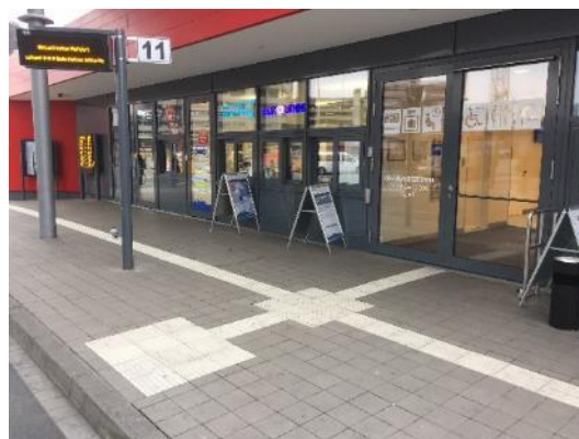
Bild FS04- 3: Bodenindikator-basiertes Leitsystem; visuell kontrastierende Bussteignummer (Foto: Boenke)
