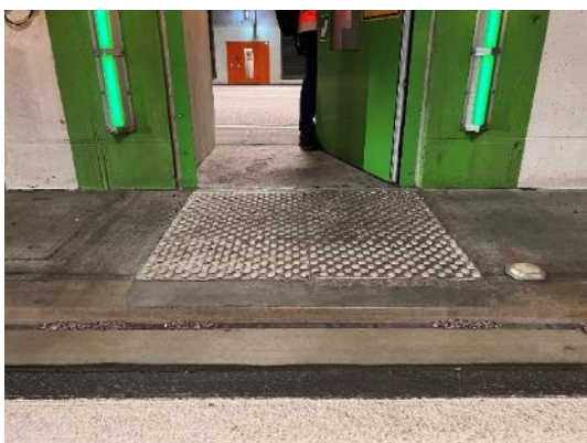
Bild FS12- 8: Blick durch die Notausgangstür auf den höhengleichen Notgehweg in der Tunnelröhre der Gegenrichtung (Foto: Boenke)
