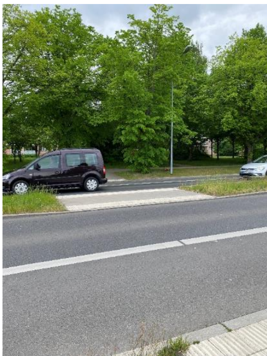
Bild FS18- 4: Mittelstreifen mit Querungshilfen (Foto: Eichmann)
