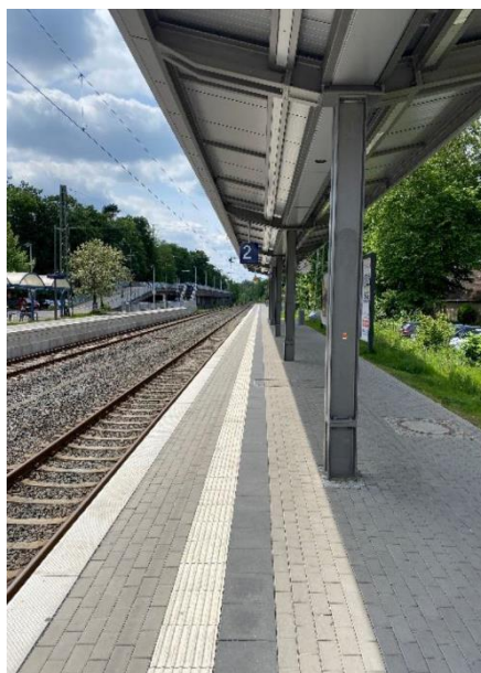
Bild FS06- 1: Bahnsteig mit visuell und taktil kontrastierendem Leitstreifen (Foto: Lutz)
