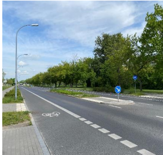
Bild FS18- 11: Radfahrstreifen und Querungshilfen (Foto: Eichmann)
