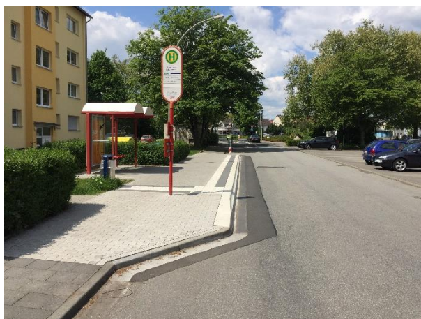
Bild FS14- 1: Von einer Fahrbahnrandhaltestelle zum Buskap umgebaute Haltestelle mit hoher Haltekante (22 cm) im Main-Taunus-Kreis (Foto: Boenke)
