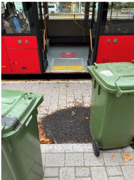
Bild FS15- 5: Provisorischer Asphaltteil an der SEV-Haltestelle Friedrich-Ebert-Platz, blockiert durch falsch abgestellte Mülltonnen (Foto: Lutz)
