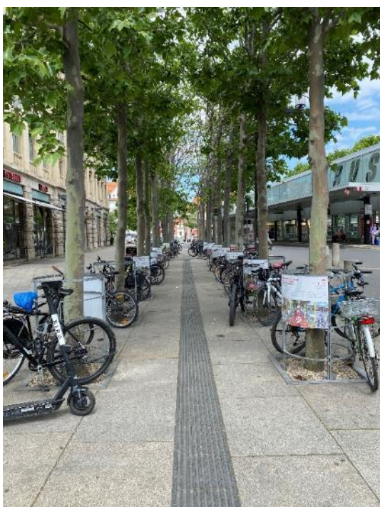
Bild FS02- 1213: Leitstreifen zum ZOB nördlich des Bahnhofs, Behinderung durch abgestellte Fahrräder (Foto: Eichmann)
