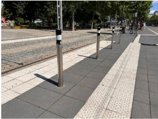
Bild FS11- 2: Poller mit visuell kontrastierender Markierung (Bänderole) (Foto: Boenke)
