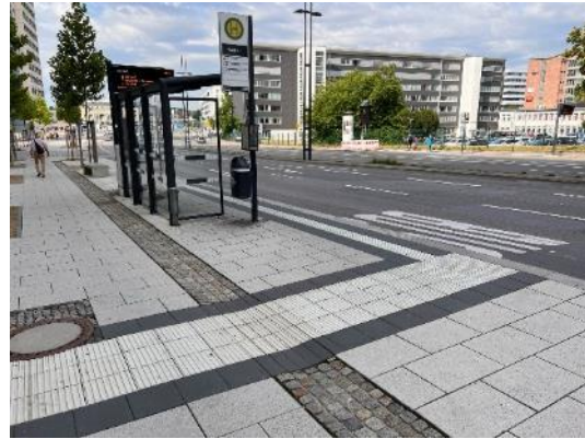
Bild FS11- 3: Auffindestreifen an einer Fahrbahnrandhaltestelle bei einem breiten Seitenraum (Foto: Boenke)
