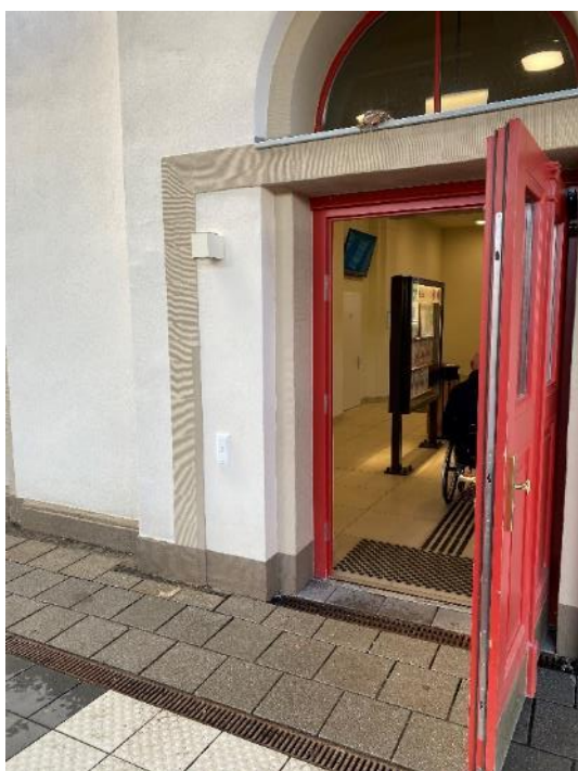
Bild FS09- 4: Zugang zum Wartesaal, automatische Tür (Foto: Eichmann)
