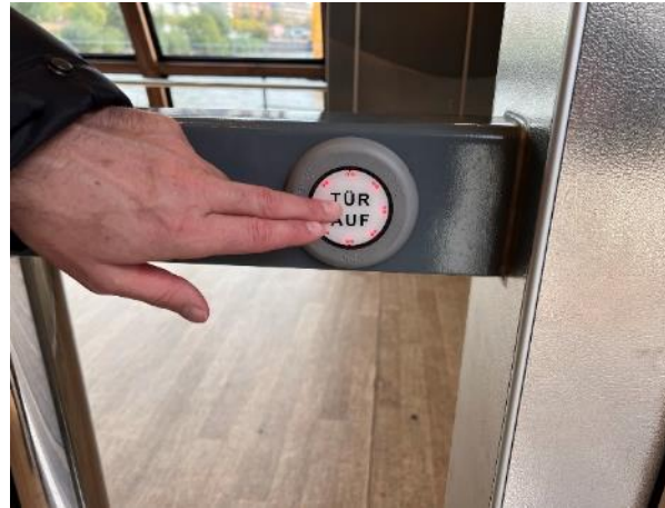
Bild FS19- 7: Kapazitiver Türöffnungstaster mit visueller Quittierung
