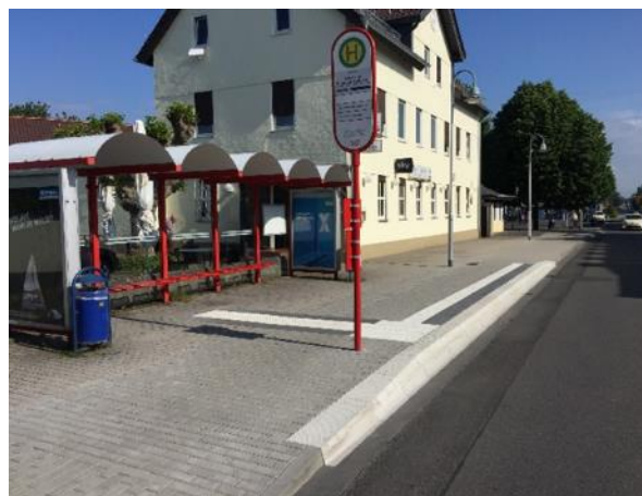
Bild FS14- 3: Fahrbahnrandhaltestelle mit visuell und taktil kontrastierendem Leitsystem und hoher Haltekante (Foto: Boenke)
