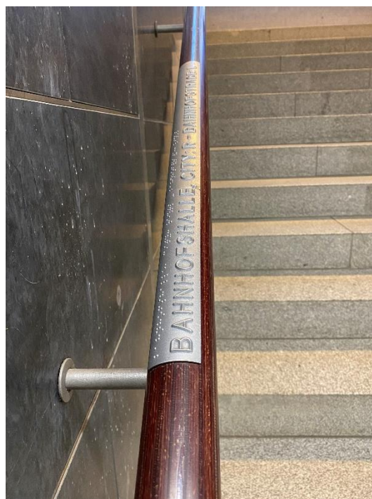
Bild FS02- 7: Taktile Beschriftung (Braille und Pyramidenschrift) am Handlauf (Foto: Eichmann)
