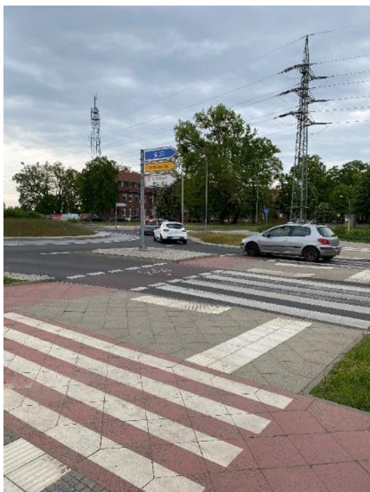
Bild FS18- 2: Kreisverkehr Heinrich-Rau-Straße/B167, getrennte Querungsstelle (Foto: Eichmann)
