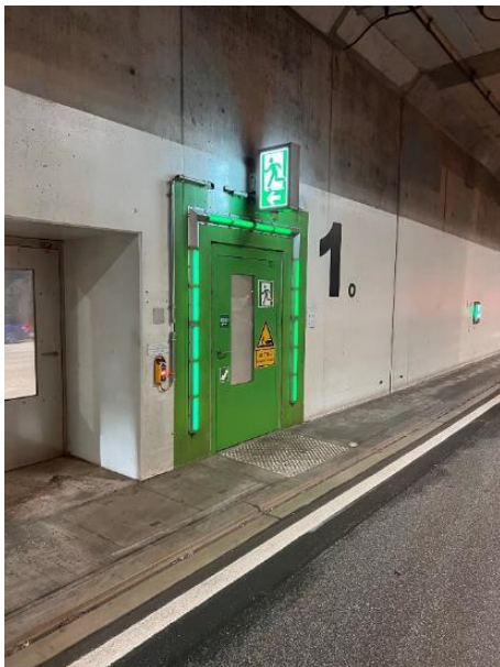
Bild FS12- 2: Auffällig gekennzeichneter Notausgang (Foto: Boenke)
