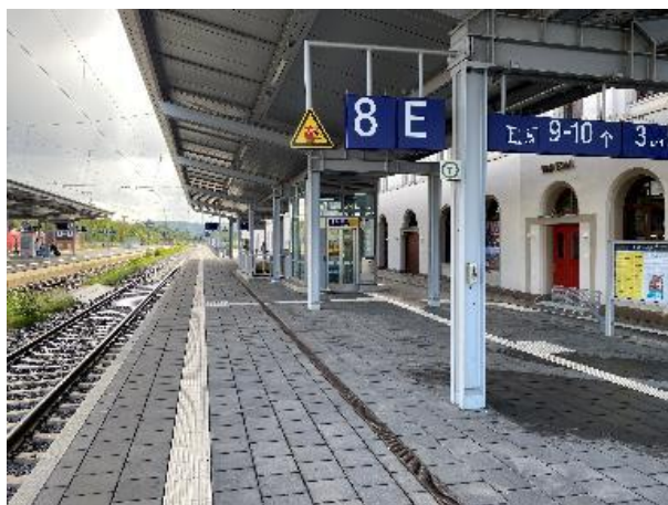
Bild FS09- 1: Bahnhof Bebra, Hausbahnsteig mit Bodenindikator-basiertem Leitsystem (Foto: Eichmann)
