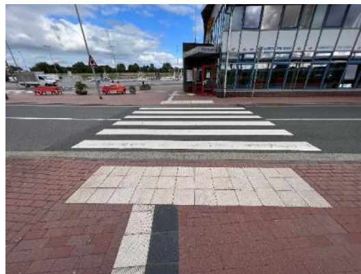
Bild FS03- 3: Blindenleitsystem über eine Querungsstelle vom Bahnsteig zum Hafenterminal (Foto: Boenke)
