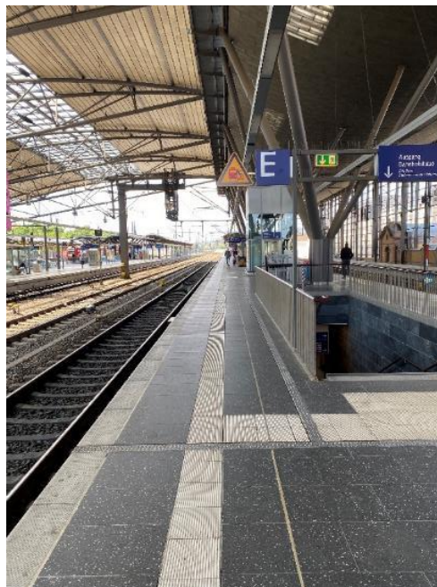
Bild FS02- 3: Bahnsteig Erfurt Hbf, Bodenindikatoren mit visuellem Kontrast zum Umgebungsbelag (Foto: Eichmann)
