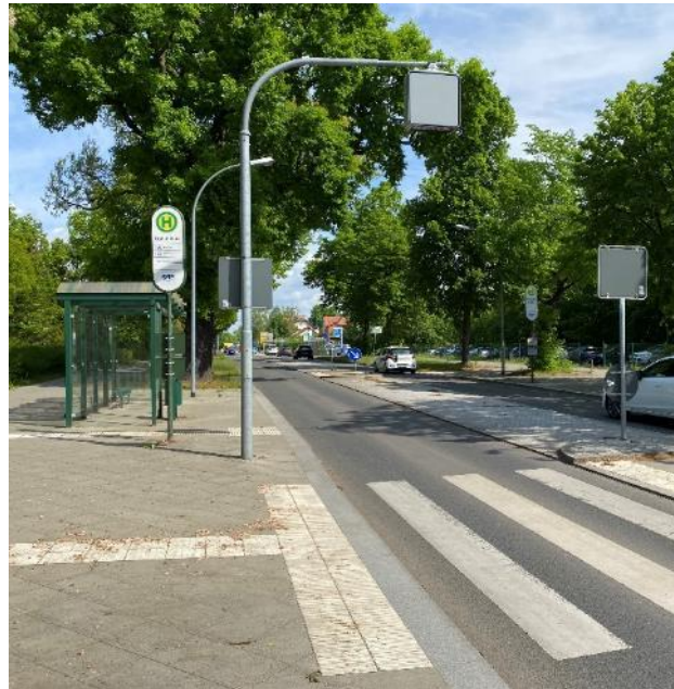
Bild FS18- 13: Bushaltestelle Krankenhaus Neuruppin, mit FGÜ, Bodenindikatoren, Glasscheiben ohne Kontraste (Foto: Eichmann)
