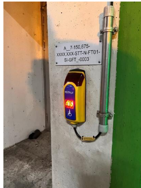
Bild FS12- 3: Großflächentaster mit visueller Rückmeldung „SOS“ (Foto: Boenke)
