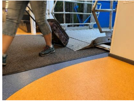
Bild FS03- 6: Niveaugleicher Zugang zum Schiff (Fahrgastbrücke, Schiffsseite) mit visuell kontrastierender Bodenmarkierung (Foto: Boenke)
