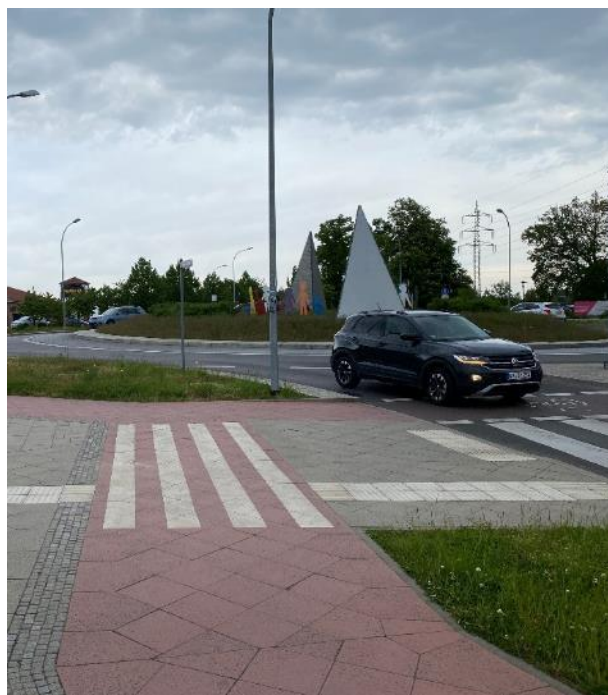
Bild FS18- 3: Kreisverkehr Heinrich-Rau-Straße/B167, FGÜ über Radweg (Foto: Eichmann)
