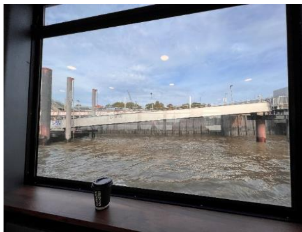
Bild FS19- 4: Neigung einer Fahrgastbrücke vom Festland zum Anleger (hier bei Hochwasser) (Foto: Boenke)
