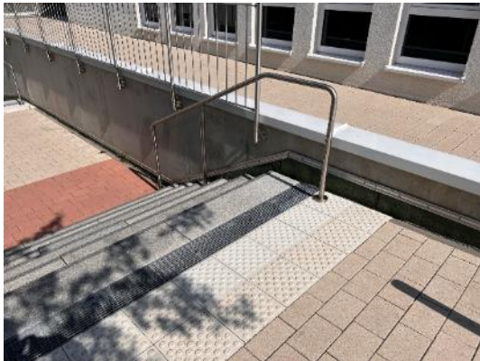
Bild FS11- 4: Barrierefreie Treppenanlage (Foto: Boenke)
