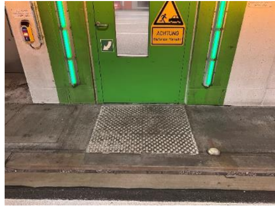
Bild FS12- 5: Aufmerksamkeitsfeld vor dem Notausgang und geschlossene Schlitzrinne (Foto: Boenke)
