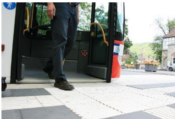
Bild FS14- 2: Niveaugleicher Einstieg in einen Bus an einer Haltestelle mit hoher Haltekante (Foto: MTV)
