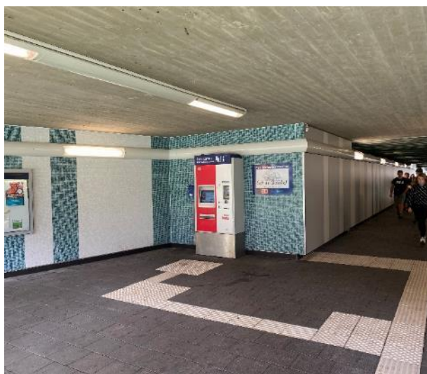
Bild FS09- 7: Bodenindikatoren im Fußgängertunnel (Foto: Eichmann)
