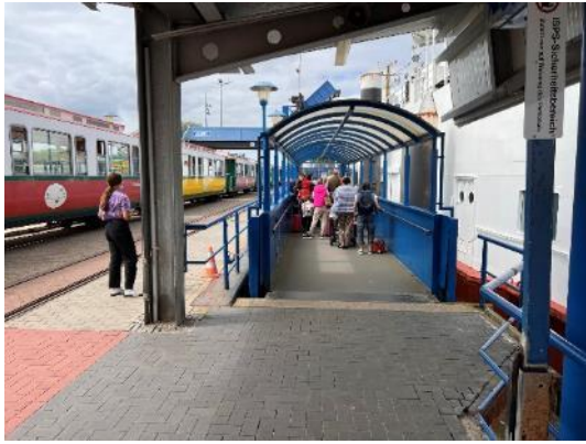
Bild FS03- 5: Stufenfreier Zugang zum Schiff über die Fahrgastbrücke (Foto: Boenke)
