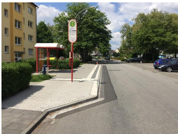
Bild FS14- 1: Von einer Fahrbahnrandhaltestelle zum Buskap umgebaute Haltestelle mit hoher Haltekante (22 cm) im Main-Taunus-Kreis (Foto: Boenke)
