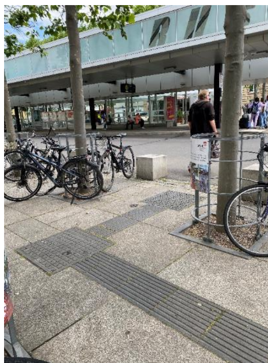
Bild FS02- 1415: Leitstreifen mit Abzweigung am Übergang vom Vorplatz zum ZOB (Foto: Eichmann)
