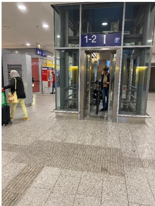
Bild FS02- 2: Empfangsgebäude Erfurt Hbf, Bodenindikatoren eingefräst, mit schwachem visuellem Kontrast zum Umgebungsbelag und ohne Begleitstreifen (Foto: Eichmann)
